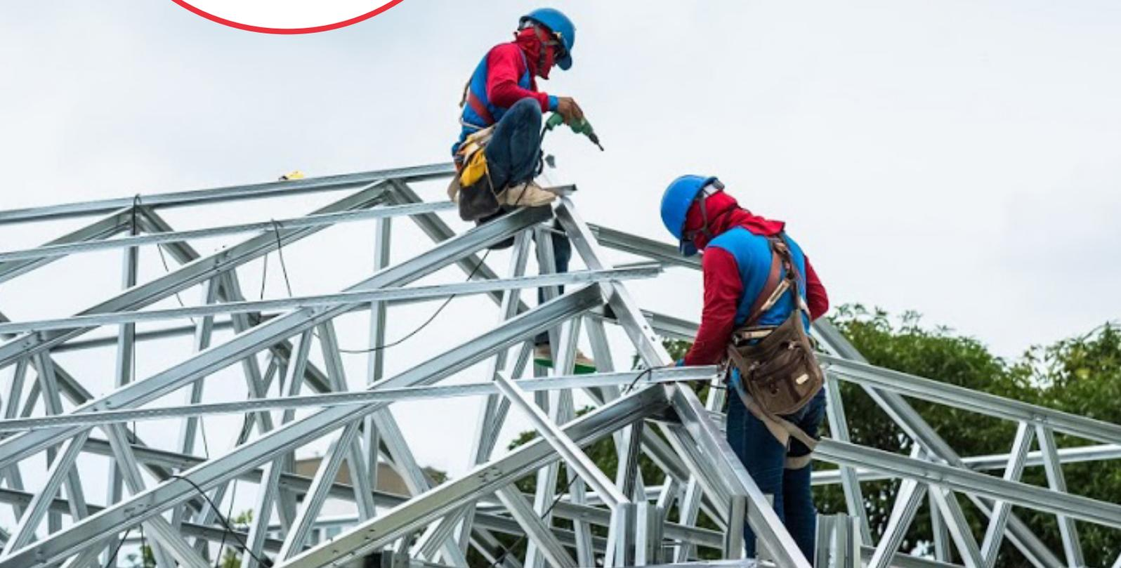
Seguindo tendências da engenharia em países desenvolvidos, a Telhaço oferece uma linha completa de Perfis Steel Frame para a estrutura de coberturas residenciais e comerciais. Substituindo a utilização de madeira, os perfis metálicos são uma solução sustentável, de rápida execução, durabilidade superior e baixo nível de manutenção a longo prazo.
